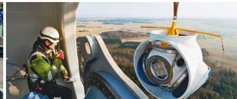
Senvion SE Windenergieanlagen in Trampe
