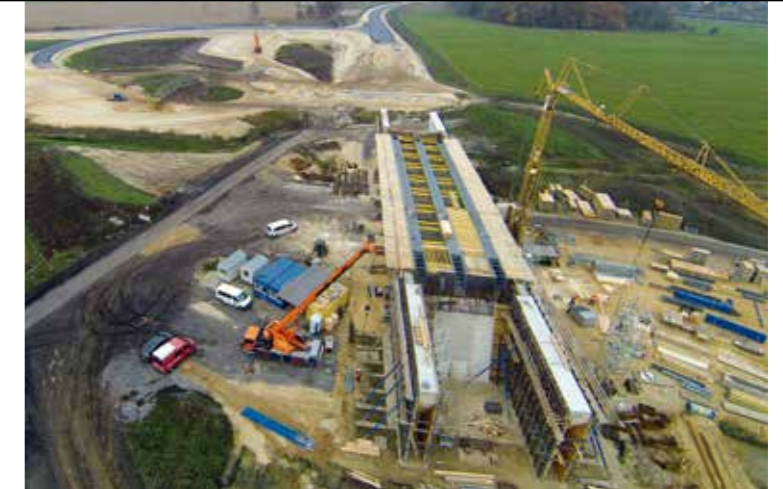
Bau der A 14
