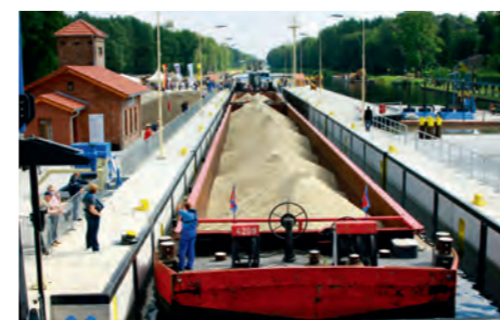
Nordkammer der Schleuse Kersdorf am Oder-Spree-Kanal nach der Grundinstandsetzung und Verlängerung
