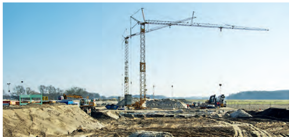
Baubeginn A 14 bei Karstädt
