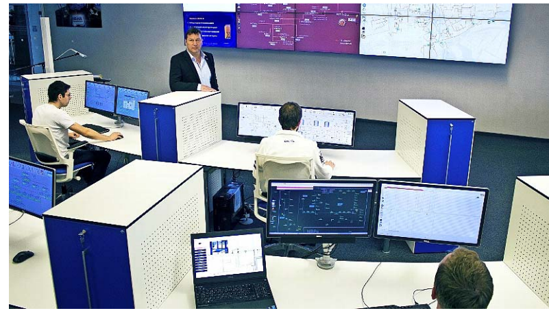
Die Steueranlagen für das Kommunale Energiemanagementsystem Cottbus (KEMS). FOTO: IBAR SYSTEMTECHNIK
